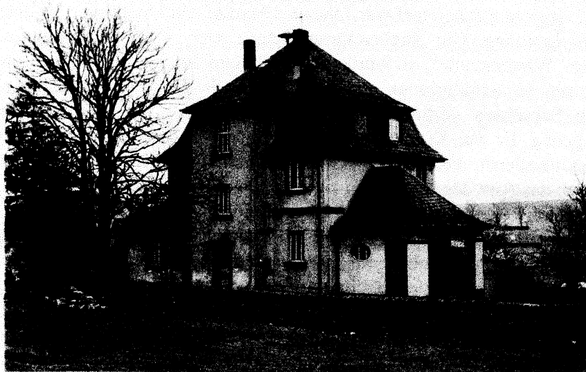
Ansicht von hinten ( 1972 )
