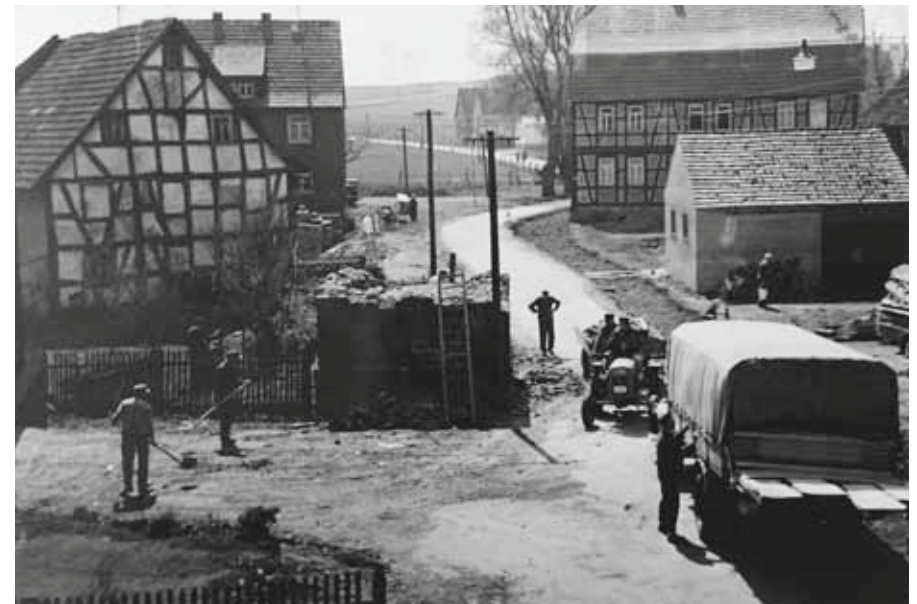
Abbruch des alten Backhauses im Oberdorf
