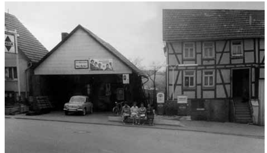
Alte Schmiede und Tankstelle
