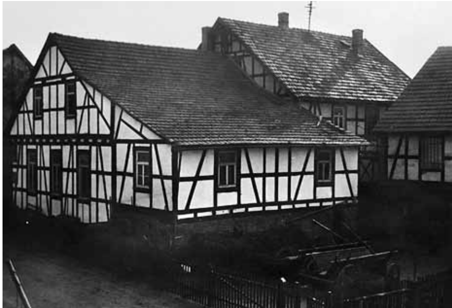
Alter Saalbau Deutsches Haus, jetzt Bäckerei Göttlicher (Ansicht Strebendorfer Straße)
